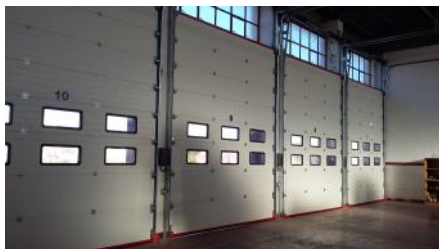
Nuevas puertas automáticas en Almansa
