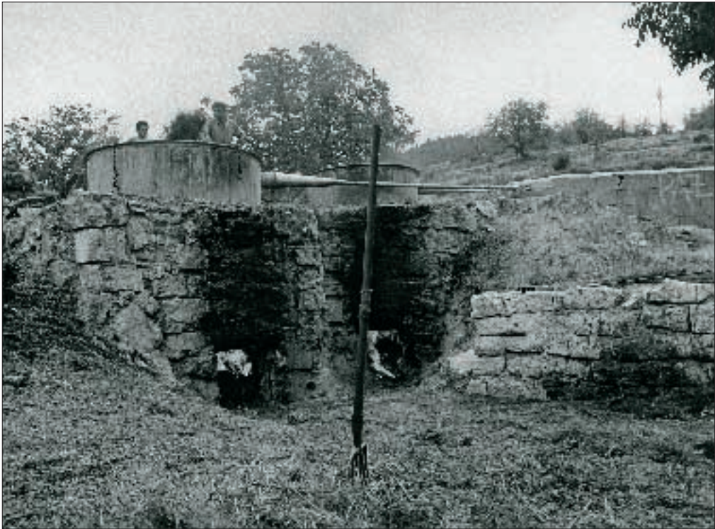
Echando la planta directamente con horcas a la doble caldera.
