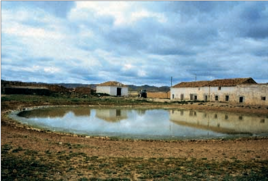
Los lavajos se llenan con agua de lluvia
