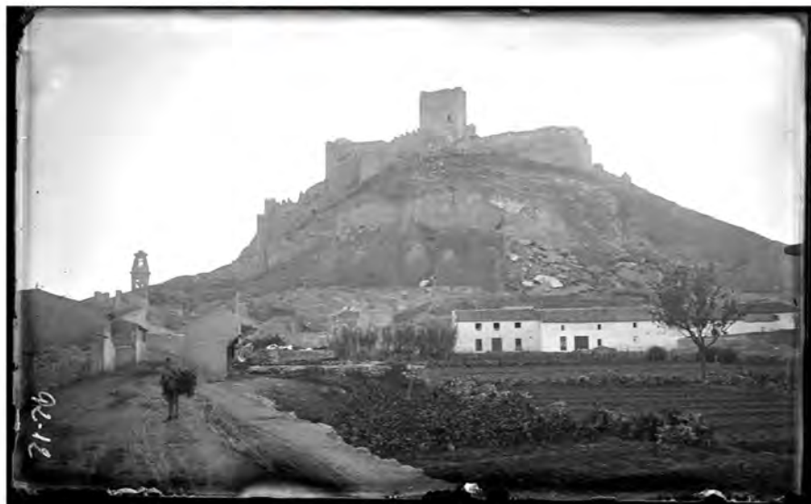
En 1912 el Ayuntamiento propuso demoler el castillo. Se inicia un largo proceso de informes que evitaron la demolición y consiguieron la declaración, en 1921, de monumento arquitectónico-artístico.
